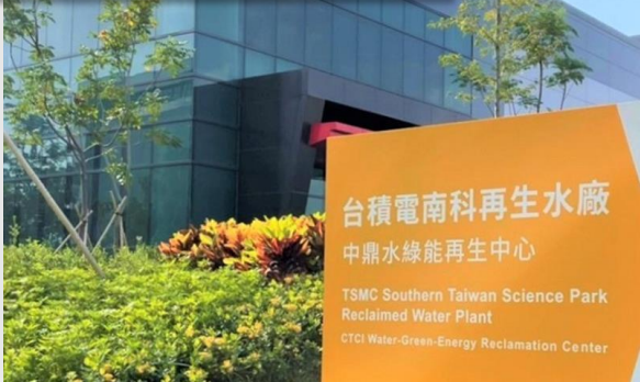
台積電南科再生水廠
